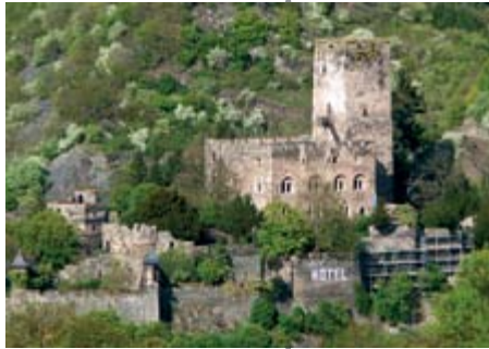
Der Palas von Burg Guttenfels oberhalb von Kaub ist eines der am besten erhaltenen Beispiele staufischer Burgenbaukunst am Mittelrhein.
