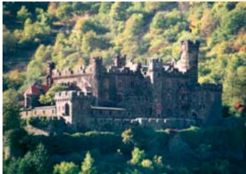
Burg Reichenstein, ein typisches Beispiel einer Spornburg. Sie steht auf einem langgezogenen Berggrücken und ist an drei Seiten durch Abhänge geschützt. An der schmalen Angriffsseite steht die Schildmauer.
